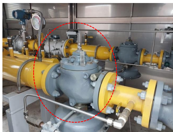
[PRV(Pressure Relief Valve)]
